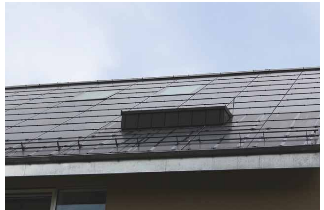
Installation photovoltaïque intégrée, avec sous-toiture MENTO 3000 connect
