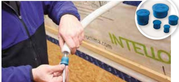
Für die schnelle und dauerhaft sichere luftdichte Einbindung von Kabeln in Leerrohre. Für den luftdichten Anschluss von Leerrohren an die Dampfbrems- und Luftdichtungsebene stehen Leerrohrmanschetten (z. B. ROFLEX 20 oder ROFLEX 20 multi) zur Verfügung.
