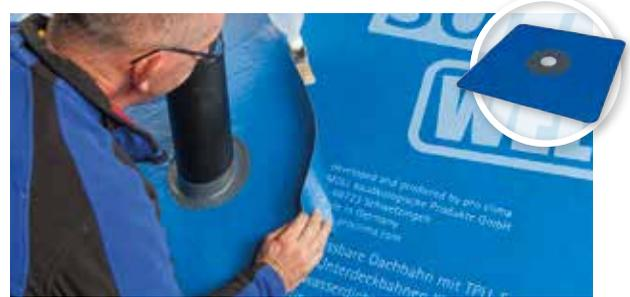
Sichere Ausführung von Rohrdurchdringungen im SOLITEX WELDANO-Unterdachsystem. Mit der vorgefertigten Manschette werden Rohrdurchführungen einfach, schnell und dauerhaft dicht hergestellt. Geeignet für Dachneigungen von 5° bis 50°. Um eine dauerhafte Dichtheit auch bei Rückstauwasser zu erreichen, muss an den entstehenden Flansch ein SOLITEX WELDANO-S 3000 Streifen angeschweißt werden (siehe Verarbeitungshinweise).
