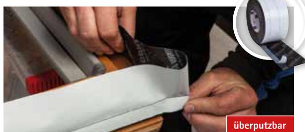
Für den außenseitig winddichten und schlagregensicheren Anschluss von Bahnen und Holzwerkstoffplatten an Fenster, Türen und mineralische Oberflächen. Die Klebezone auf der Vliesseite ermöglicht einfachere Verklebung an Fenster und Türen bei Verarbeitung vor deren Montage.
