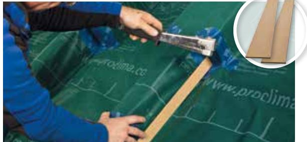
Für den einfachen sicheren, eng an den Sparrenflanken anliegenden Einbau einer Sub-and-Top-Sanierungs-Dampfbremse, z. B. DASATOP.
