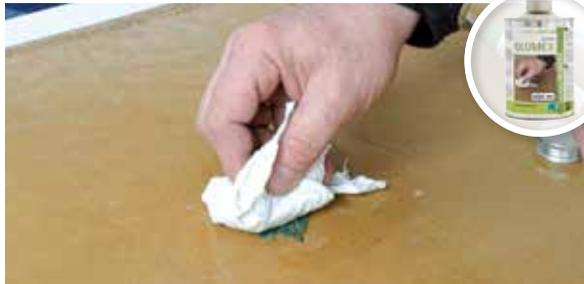
pro clima GLUMEX mit einem weichen Lappen auf der zu reinigenden Oberfläche verteilen und leicht einreiben. Bereits nach wenigen Minuten sind Ablöseerscheinungen erkennbar. Mit einem rauen Material (z. B. Putzwolle oder eine Bürste) kann jetzt die Verunreinigung abgerieben werden. Sollten Rückstände zurückbleiben kann der Vorgang wiederholt werden. Es ist empfehlenswert die Verträglichkeit von GLUMEX mit der vorhandenen Oberfläche vorab an einer nicht sichtbaren Stelle zu testen.
