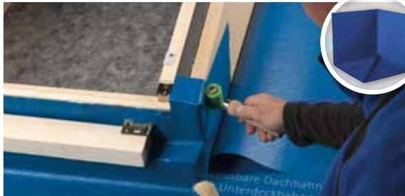
Sichere Ausführung von Inneneckanschlüssen im SOLITEX WELDANO-Unterdachsystem. Das werkseitig vorverschweißte, diffusionsoffene Formteil kann mit dem System-Quellschweißmittel oder Heißluft materialhomogen mit der Unterdachbahn SOLITEX WELDANO verbunden werden.
