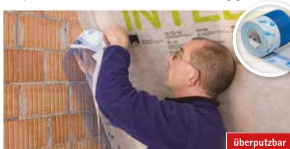
Für definierte gewerkeübergreifende Anschlüsse von Bahnen bzw. Holzwerkstoffplatten an zu verputzende Bauteile (Mauerwerk bzw. Beton).
