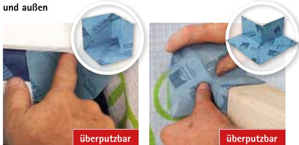
Verklebung auf Dampfbrem- und Luftdichtungsbahnen aus Folie und Papier, Dampfbrem- und Luftdichtungsebenen aus harten Holzwerkstoffplatten, Unterdeck-, Unterspan- und Wandschalungsbahnen, Holzfasernerunterdeckplatten, angrenzenden Bauteilen aus gehobeltem Holz, harten Kunststoffen bzw. Metallen, wie Fenster, Türen, Balken, Zangen usw.
