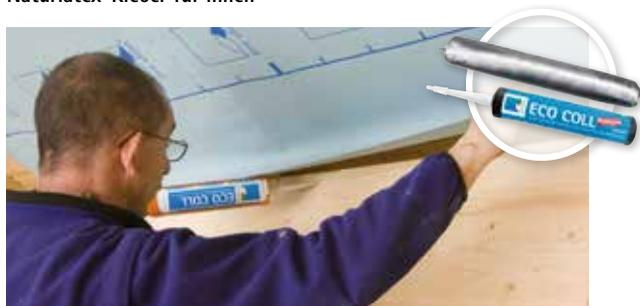
Luftdichte Verklebung von Dampfbrems- und Luftdichtungsbahnen aus Baupappe (z. B. pro clima DB+) untereinander und an alle Anschlüsse ohne Anpresslatte (je nach Anforderung) oder weitere Befestigungen.
