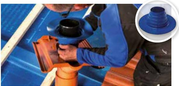
Sichere Ausführung von Rohrdurchdringungen im SOLITEX WELDANO-Unterdachsystem. Mit der vorgefertigten Manschette werden Rohrdurchführungen einfach, schnell und dauerhaft dicht hergestellt. Geeignet für Dachneigungen von 5° bis 25°.
