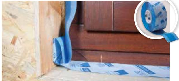
Für den raumseitigen luftdichten und dampfbremsenden Anschluss von Fenstern und Türen an flankierende Bauteile, mit drei Klebestreifen.
