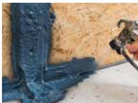
Anschluss Holzbauwände an Betonboden
