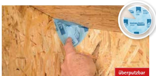
Verklebung auf Dampfbrem- und Luftdichtungsbahnen aus Folie und Papier, Dampfbrem- und Luftdichtungsebenen aus harten Holzwerkstoffplatten, Unterdeck-, Unterspan- und Wandschalungsbahnen, Holzfasernerunterdeckplatten, angrenzenden Bauteilen aus gehobeltem Holz, harten Kunststoffen bzw. Metallen, wie Fenstern, Türen, Balken, Zangen usw.
