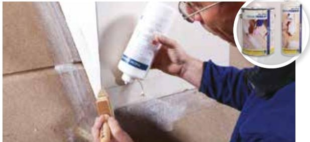
Zur Vorbereitung bzw. Ertüchtigung des Untergrundes für die anschließende Verklebung mit pro clima Klebebändern, wie z. B. TESCO VANA, TESCO PROTECT und Klebebänder der EXTONSEAL-Familie. Für Holz, Holzfaserverplatten, Mauerwerk, Dach, Wand und Bodenplatten geeignet.
