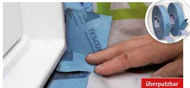
Zur Verklebung von Dampfbrems- und Luftdichtungsebenen, Unterdeck-, Unterspann- und Wandschalungsbahnen sowie Anschlüssen an angrenzende Bauteile.
