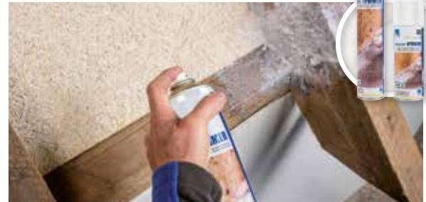
Zur Vorbereitung bzw. Ertüchtigung des Untergrundes für die anschließende Verklebung mit pro clima Klebebändern, wie z. B. TESCON VANA, TESCON PROTECT und Klebebänder der EXTOSEAL-Familie. Für Holz, Holzfaserverleklebungen, Mauerwerk, Dach, Wand und Bodenplatten geeignet.
