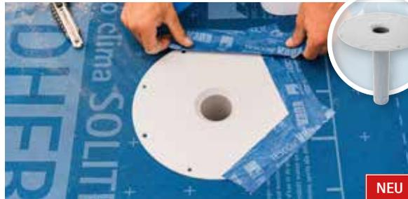
Formteil für die vertikale Entwässerung durch das Decken- oder Dachpaket während der Bauphase. Einbau mit Anschluss an ein Rohr- oder Schlauchsystem zur temporären Wasserableitung.
