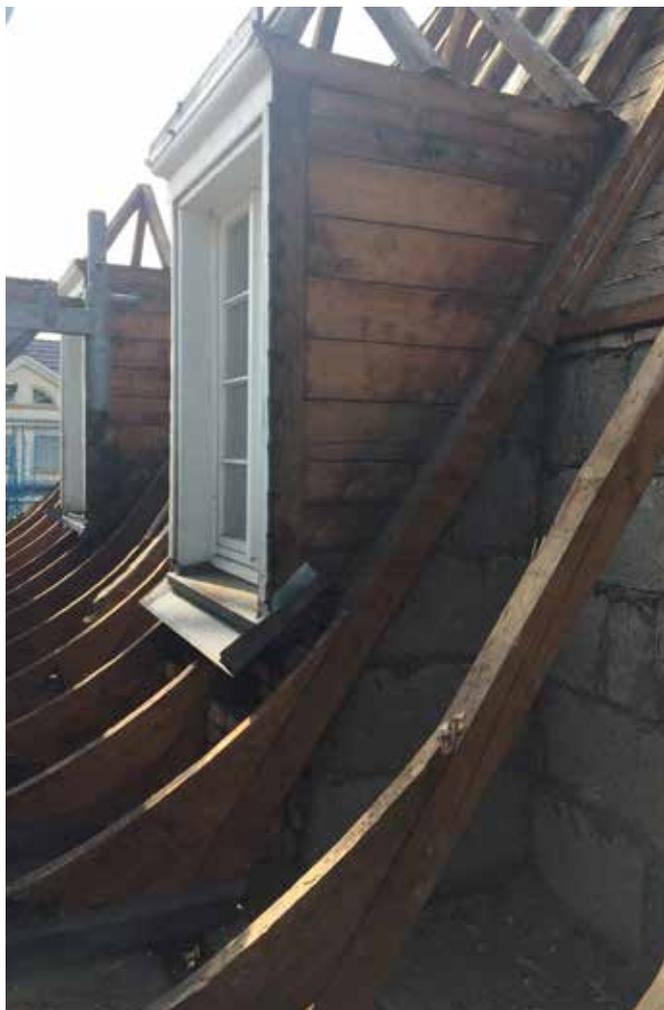
*Dieses Walmdach einer Villa in Heidelberg sollte energetisch saniert werden. Die Herausforderung: Verschiedene Innenbeplankungen wie Holz und Putz etc. Zudem fehlte hinter dem Drempel jegliche Unterkonstruktion*
