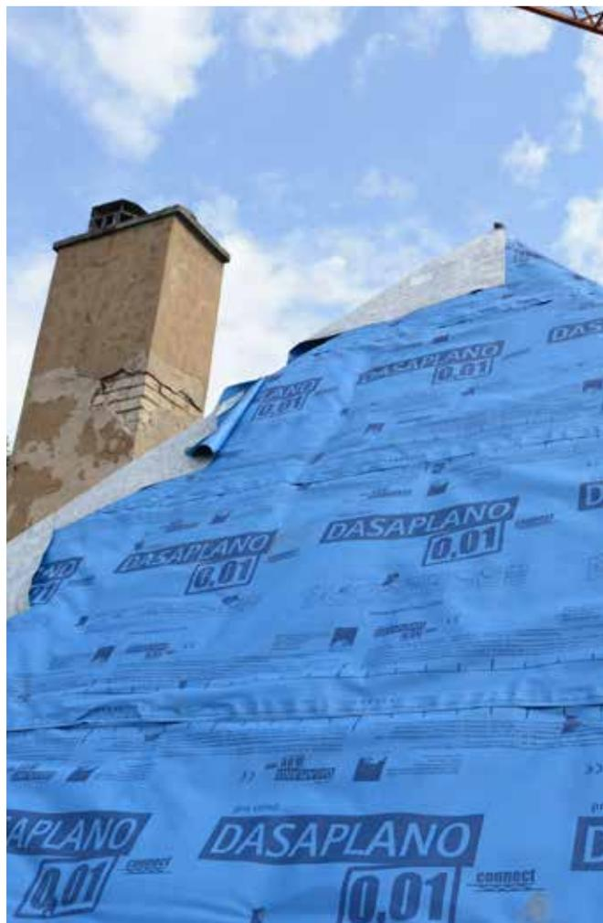
*Die Luftdichtungsbahn pro clima DASAPLANO 0,01 connect wurde flächig über den Sparren verlegt. 2/3 der Dämmung befindet sich darunter, Unterdeckplatten werden noch als Überdämmung montiert*
