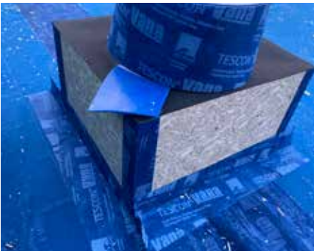
Zur sicheren Abdichtung von Durchdringungen
