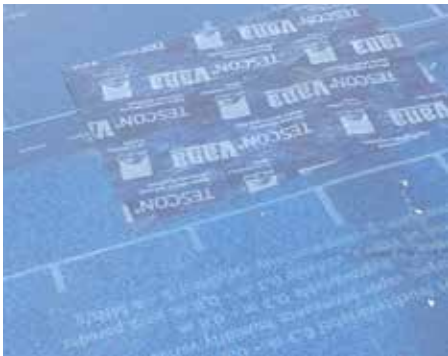
Zum Abdichten von beschädigten Stellen in der Bahn.
