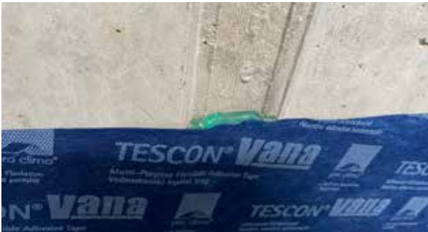
Bei Schalungsfugen im Beton zusätzlich mit ORCON MULTIBOND verkleben.
