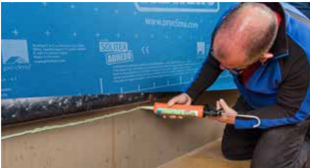
Anschluss an raue Untergründe, z. B. Betonbauteile Kleberaupe d = mind. 5 mm auftragen.
